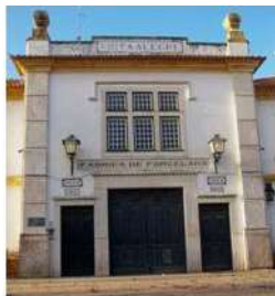
Figura 13 – Fachada da Fábrica da Vista Alegre
