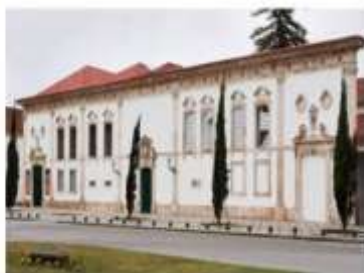
Figura 4 - Fachada do Museu de Aveiro
