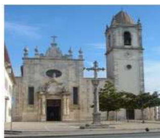
Figura 5- Fachada da Sé de Aveiro
